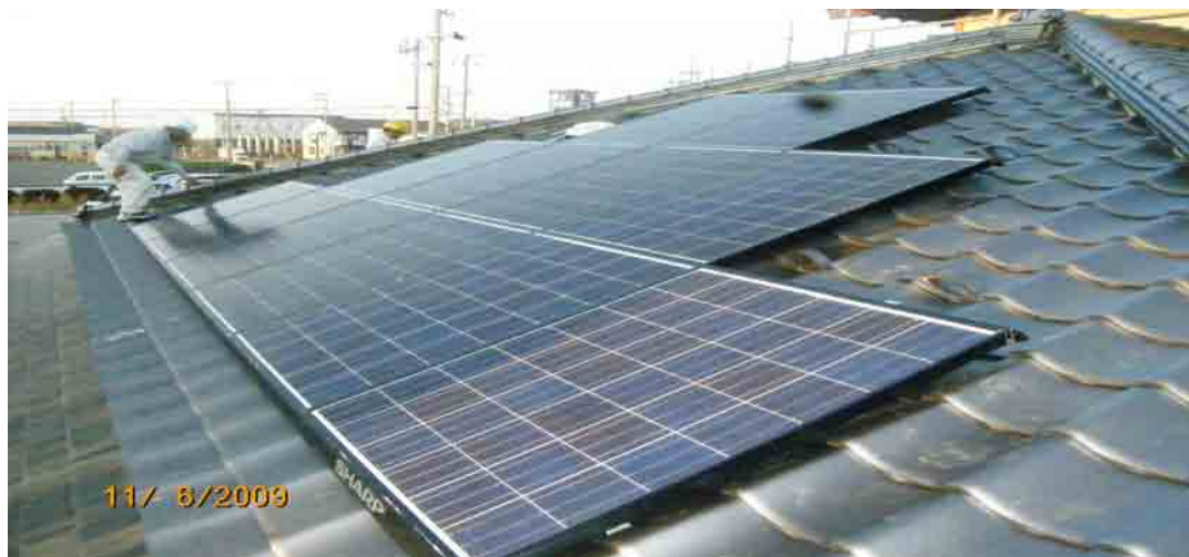
太陽光発電パネル 設置工事
